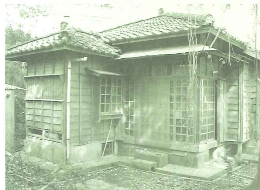
多田榮吉故居的木結構建築本體保存相當完好 (攝影/余鈞惠)
